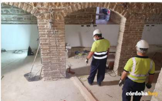
📍 Obras de la zona de hostelería del Palacio de Congresos de la calle Torrijos
