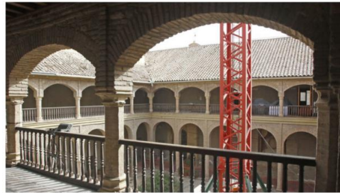
Obras en el Palacio de Congresos de la calle Torrijos / JUAN AYALA
