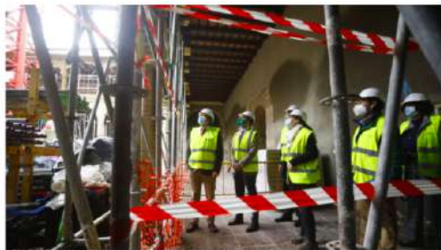
Obras en el Palacio de Congresos de Córdoba. / MIGUEL ÁNGEL SALAS
