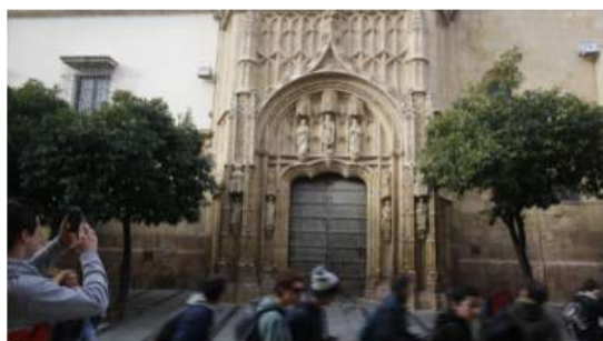
Fachada del Palacio de Congresos de Córdoba. / A.J. GONZÁLEZ
